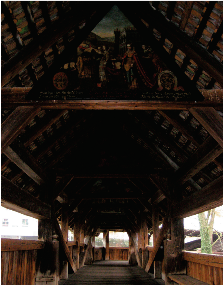
Abb. 27 | Luzerner Spreuerbrücke, Ansicht von Unten auf das Dachgestühl mit Totentanzgemälden von Meglinger. (Bilder von ca. 1635)
