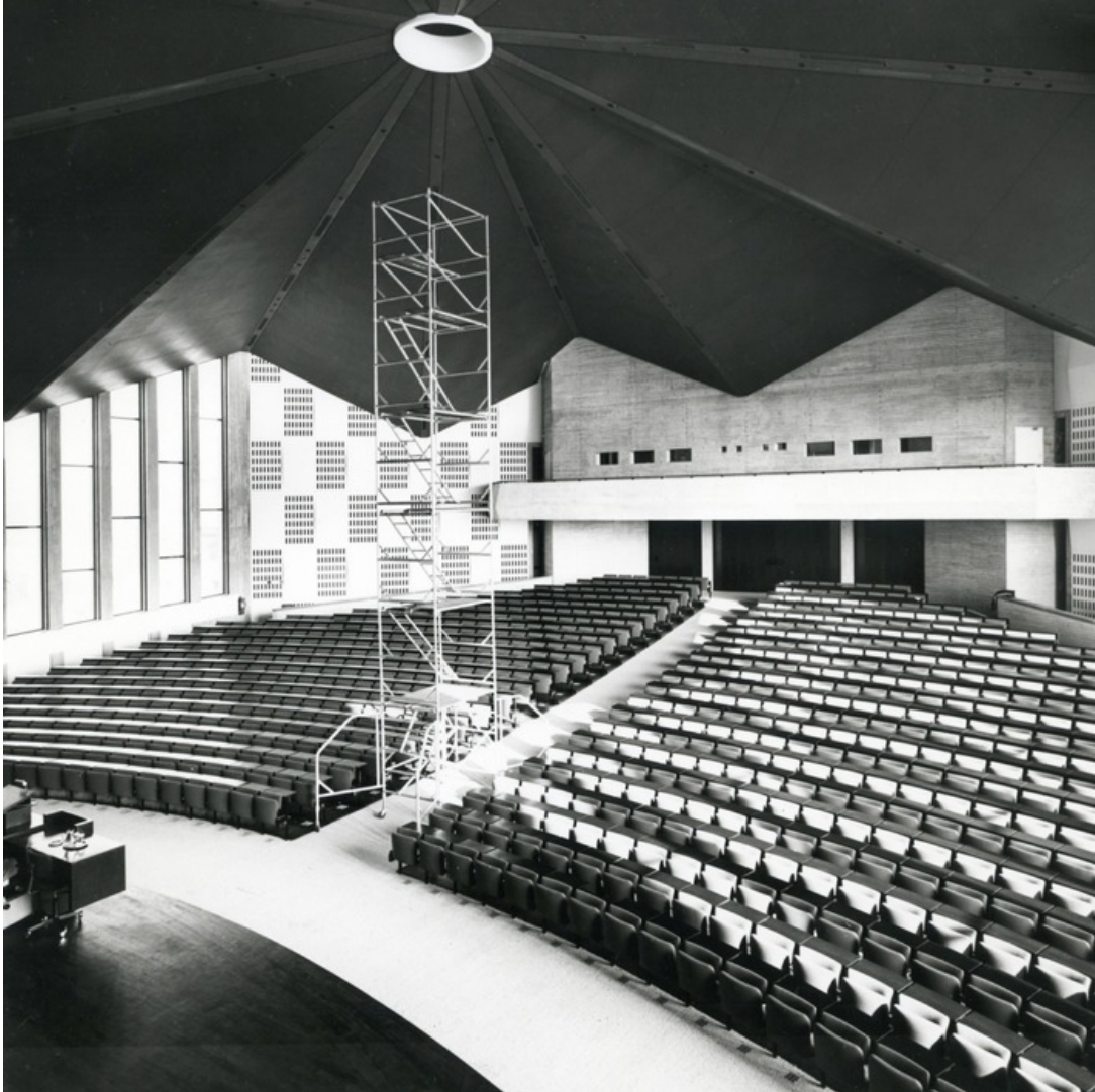
De aula in aanbouw.
