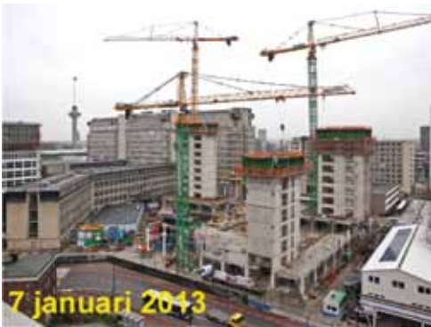
Figuur 22: Het gedwongen huwelijk van infectiepreventie en bouw
